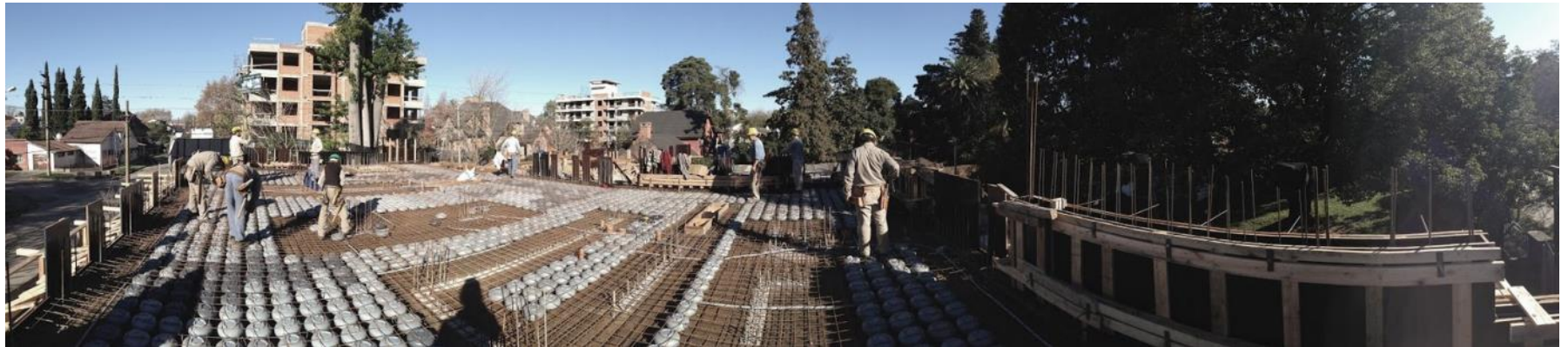
Arq. Juan Micieli | Moreno, Buenos Aires, Argentina | Superficie de losas: 3.000 m 2
